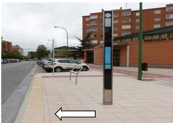
Fig 14. Tactile-visual pavement stripe.
